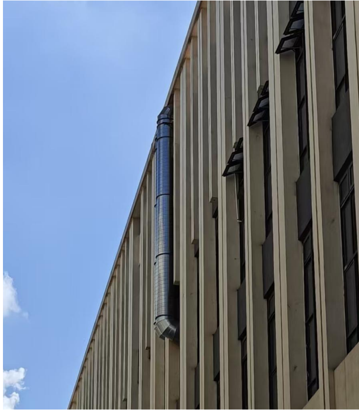
喷漆废气排气筒及干式过滤+活性炭吸附装置（DA003）
