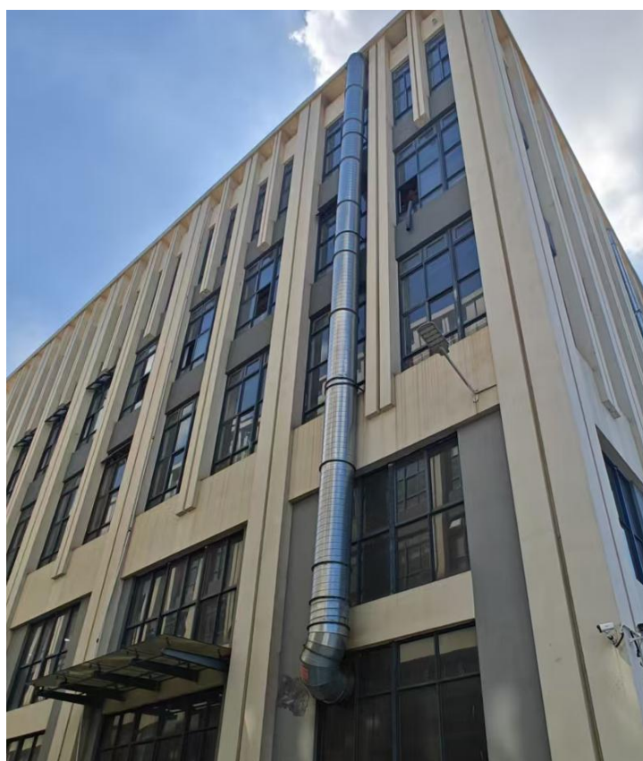
抛光、焊接粉尘排气筒及布袋除尘设施（DA001）
