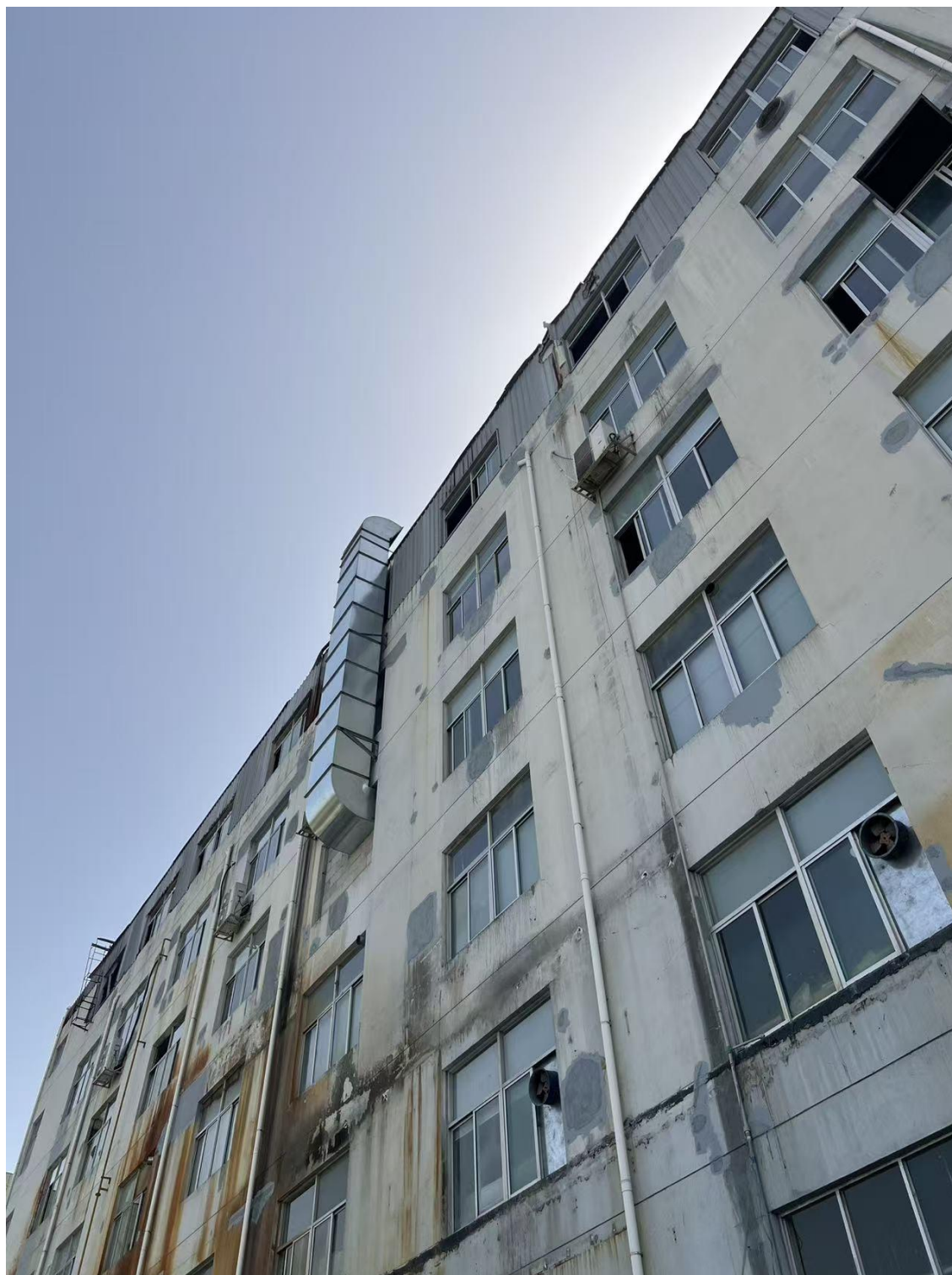
DA003 水性漆排气筒
